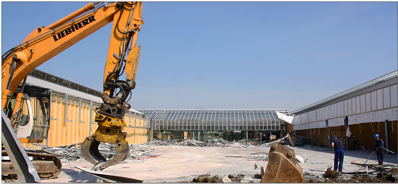
Schon fast komplett abgerissen ist der Mittelteil von Schley's Blumen-Paradies. Bis Ende September soll hier ein neues Gewächshaus mit Verkaufsfläche entstehen. Fotos (2): Vera Demuth
